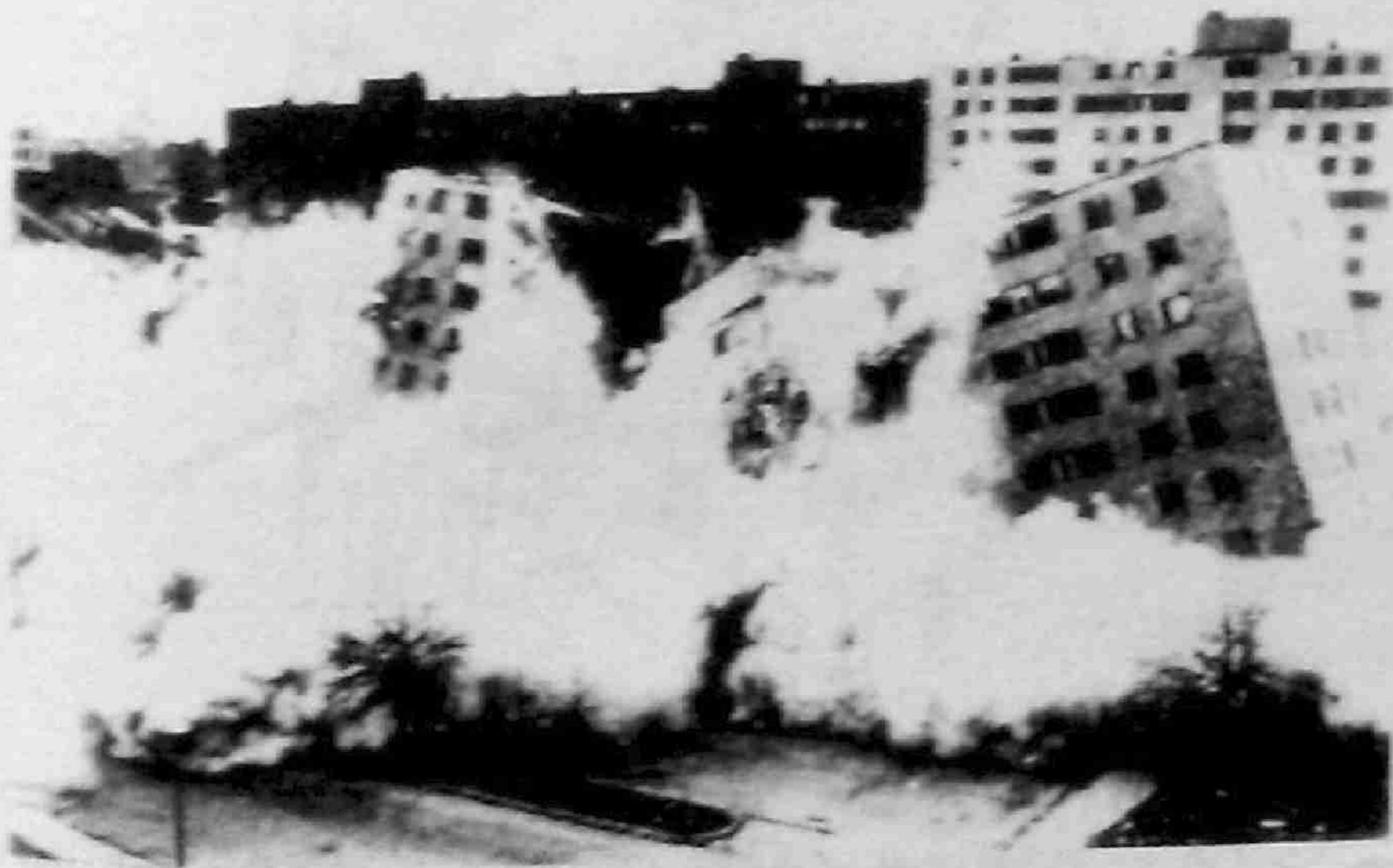
شکل ۷.۶. مجموعه آپارتمانی پروت ایگو هنگام انهدام با دینامیت
