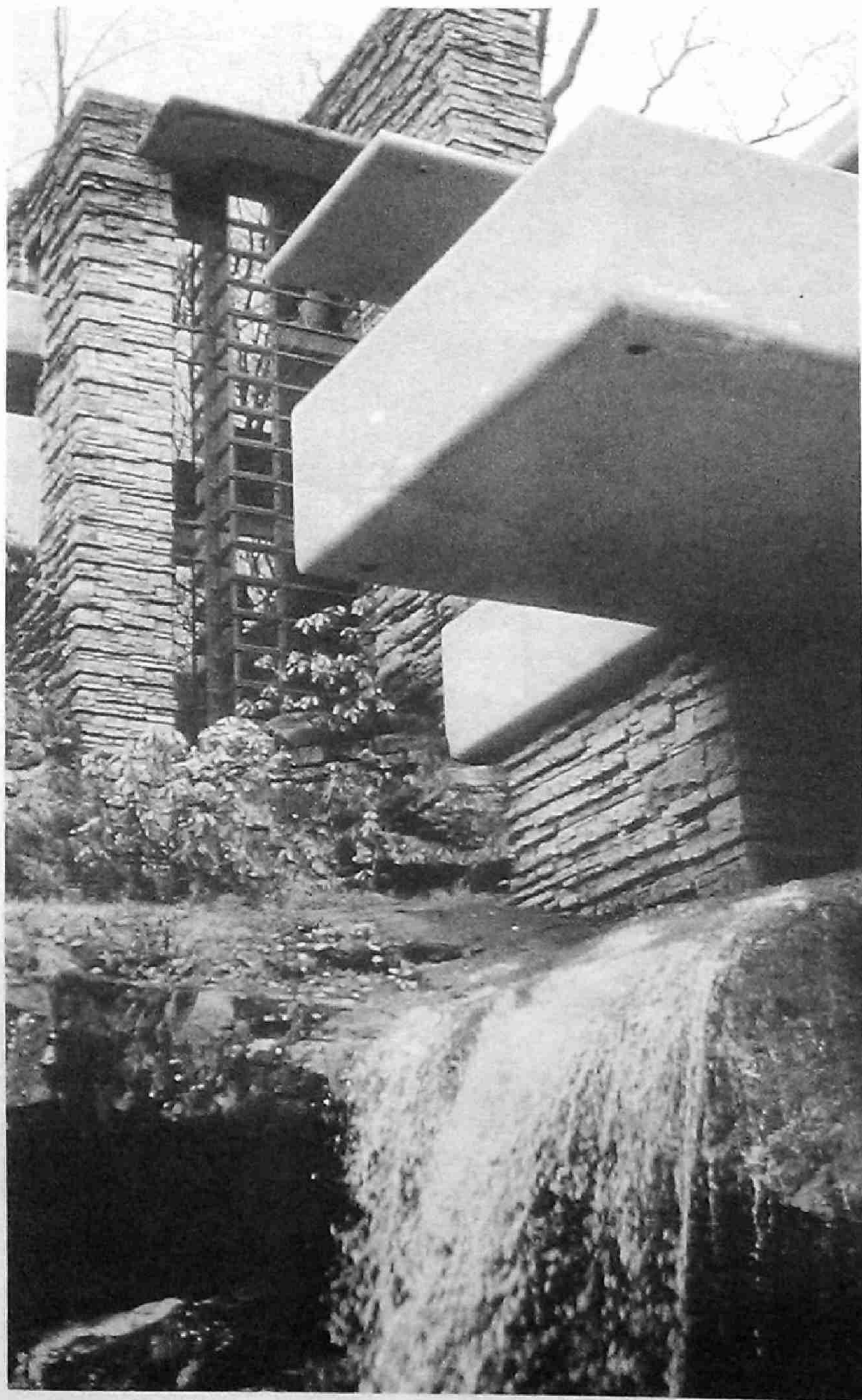
شکل ۳. ۱۷. راه پله خانه آبشار، همچون درختی تنومند، از دل زمین بیرون آمده است. در طرح این ساختمان مرز بین معماری و طبیعت مخدوش شده است.
