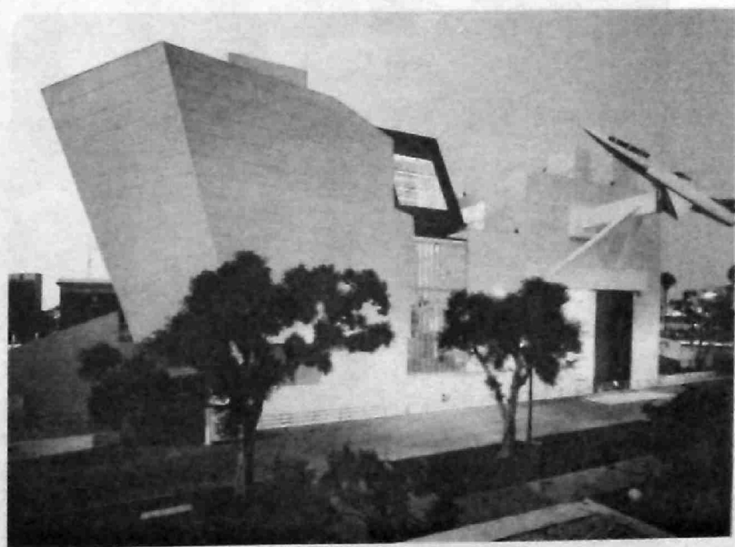
شکل ۳۹ موزه و تئاتر هوافضا (۱۹۸۲-۸۴) توسط فرانک گهری در لوس آنجلس آمریکا طراحی شده است احجام ناپایدار و متزلزل و عدم تقارن و تناسب، نمادهای شاخص معماری دیکانستراکشن است
