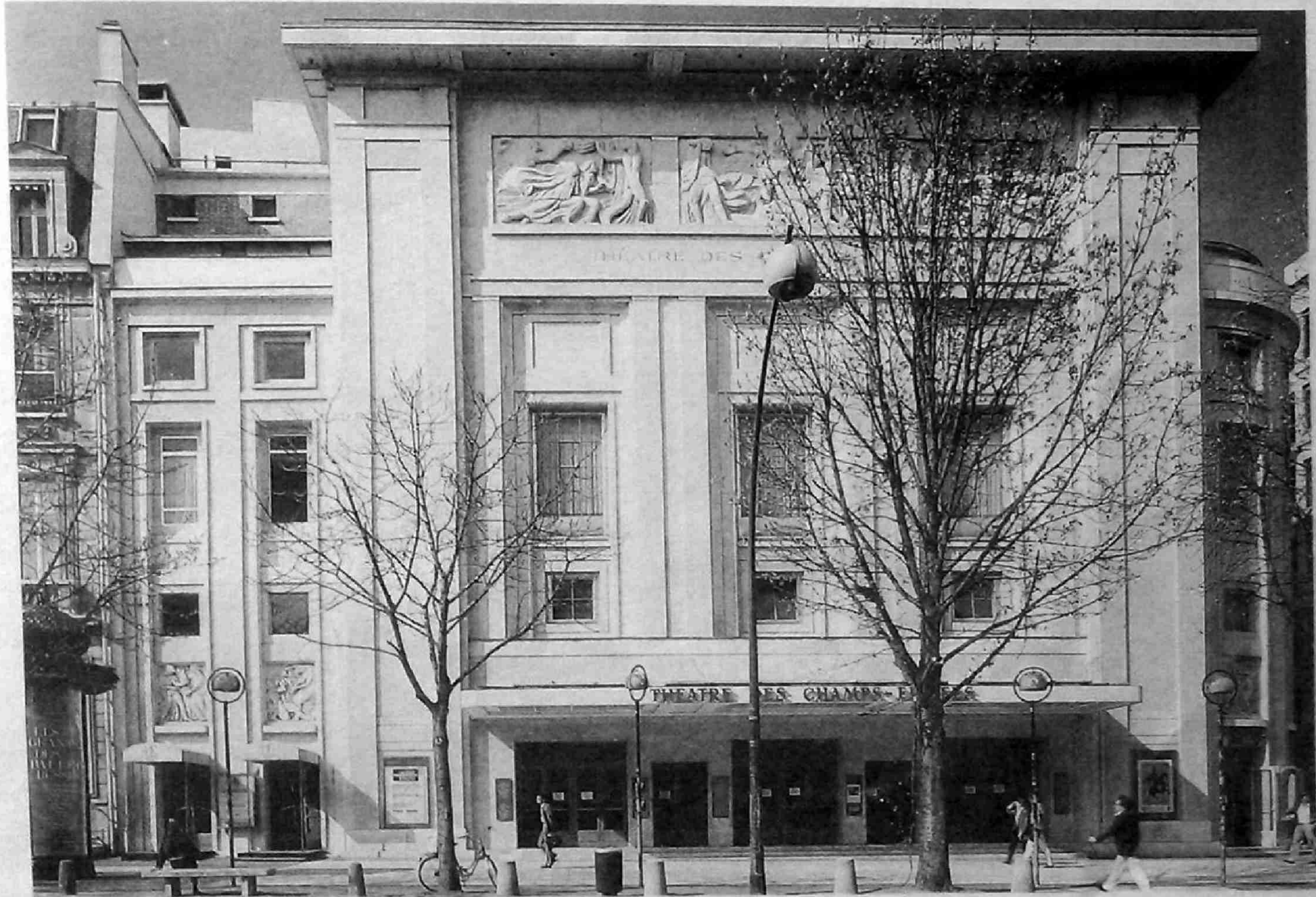
شکل ۱۸.۲. نمای ساختمان تئاتر شانزلیزه در پاریس، (۱۹۱۳)، طراحان آگوست و گوستاو پره
