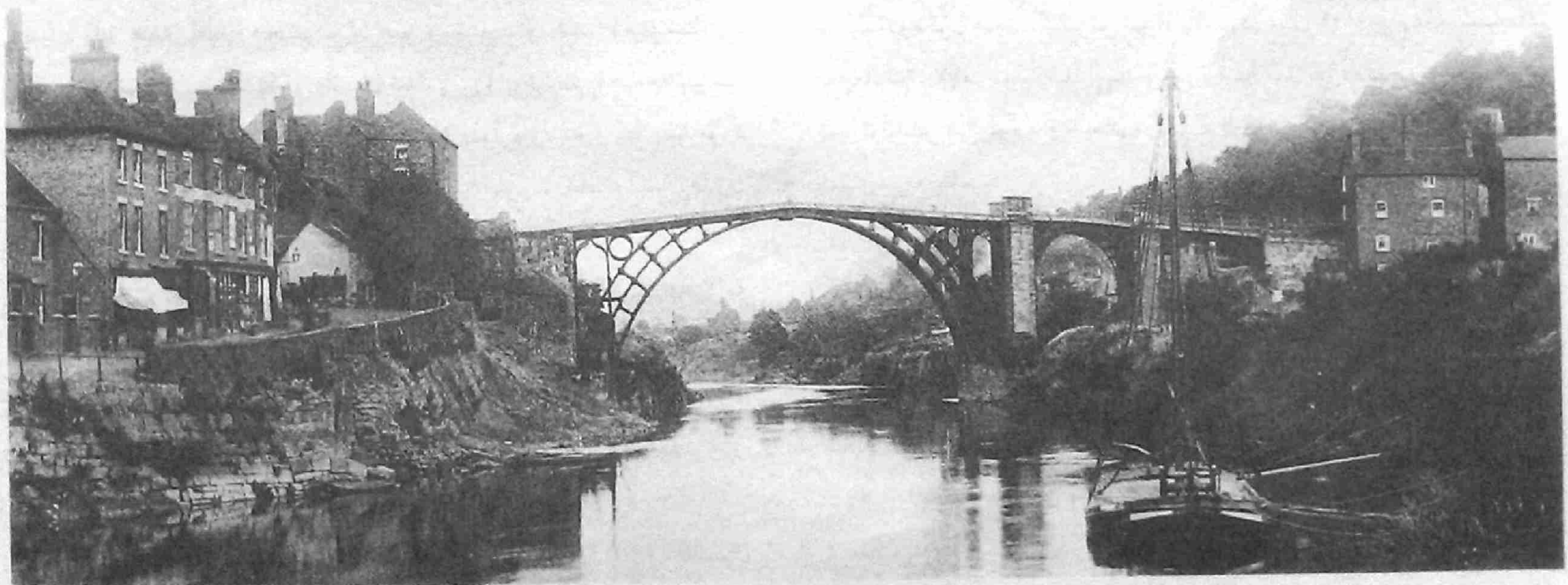
شکل ۱.۱. پل فلزی سورن با سی متر دهانه توسط ابراهام داربی در سال ۱۷۷۹ در انگلستان ساخته شد.
