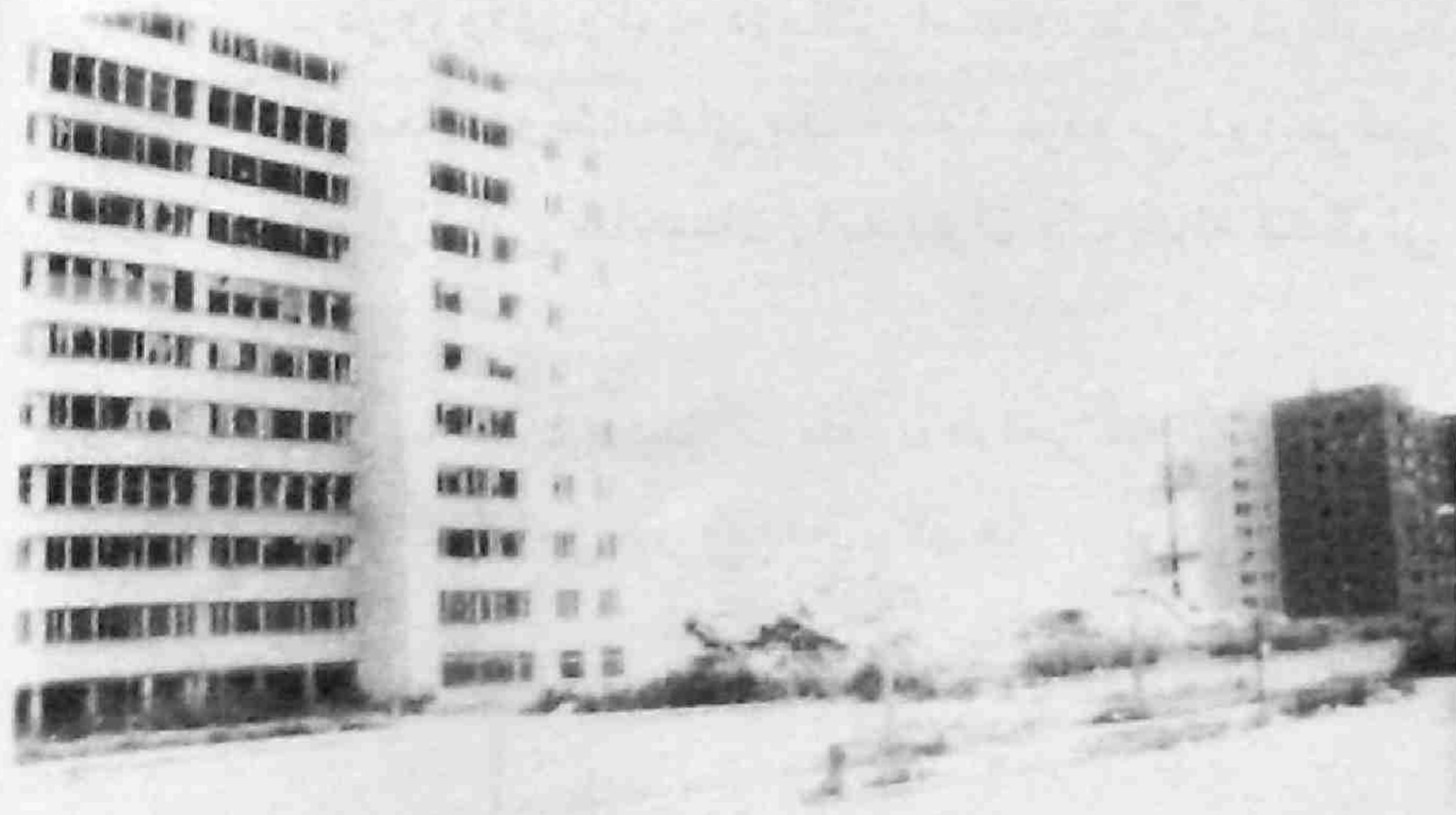
شکل ۶.۶. مجموعه آپارتمانی پروت ایگو قبل از انهدام با دینامیت
